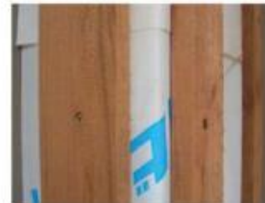
④ 専用ビスで通気胴縁を取り付けます。
