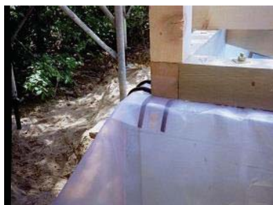
基礎/土台間への気密パッキン施工
