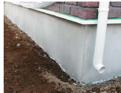
外装仕上げの状況。
