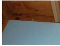
③断熱材取付け状況
