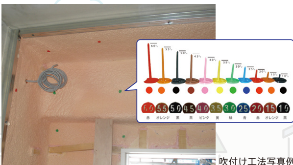
吹付け工法写真例
