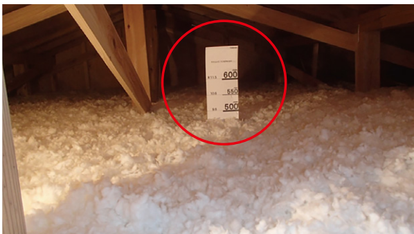
吹込み工法写真例
